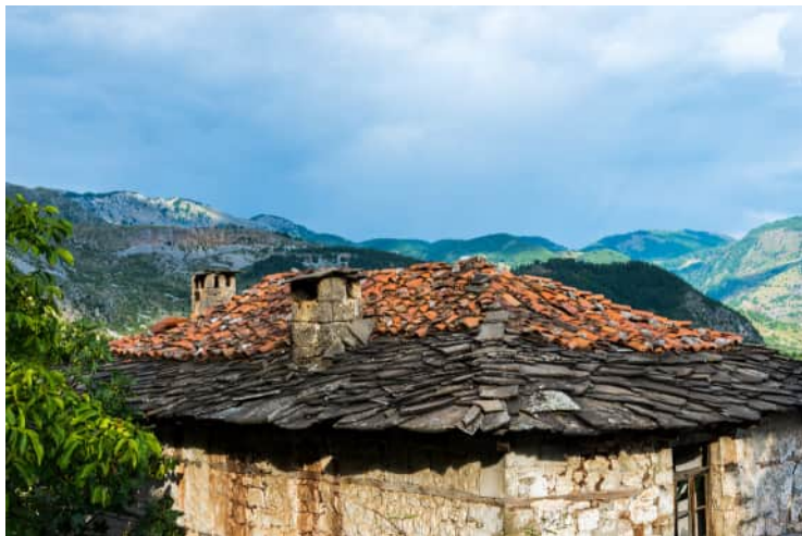
Kamenné střechy opuštěných domů střední Albánie
