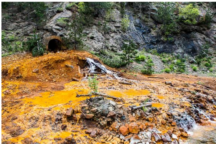
Odvodňovací štola, Gulag Qafë Bari
